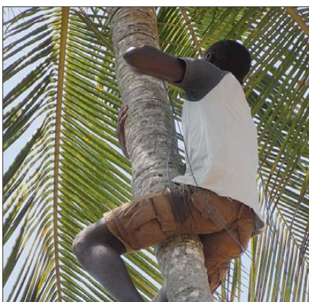
Sportliche Vorkehrungen beim Aufbau der 160-m-Vertikalantenne
